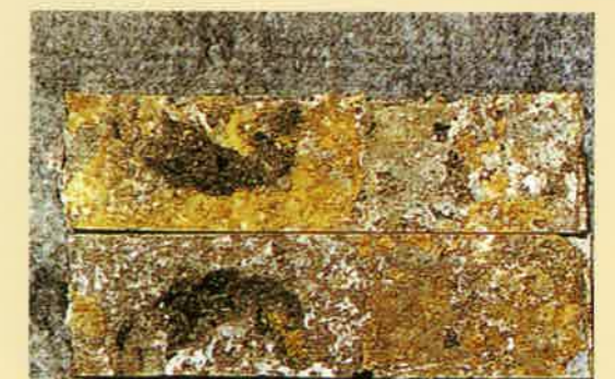
(4) 注入充填状況3: 良く充填され、コンクリートとも良く接着している。
