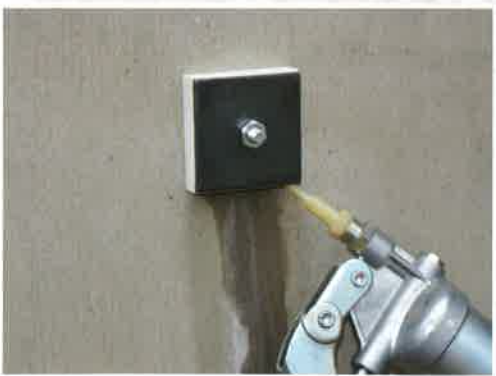
③ ナットを締めてPFパッキン付座金を固定し NLペーストを10~14g注入
