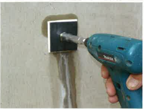
④ PFパッキンが圧縮されて5mm程度に なるまでナットを締め付ける
