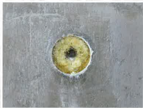
⑦ 注入されたNLペーストが硬化した状態
