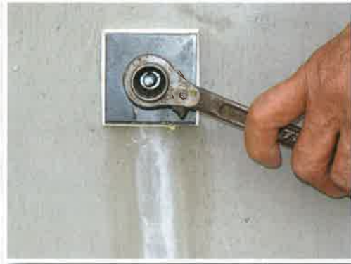
⑤ 止水を確認してナットを外す
