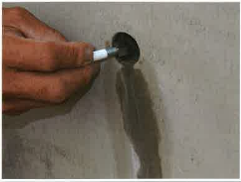
① 連結ボルトナットセットをねじこむ
